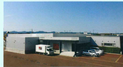
▲長岡市新産にある長岡セントラルキッチン。
